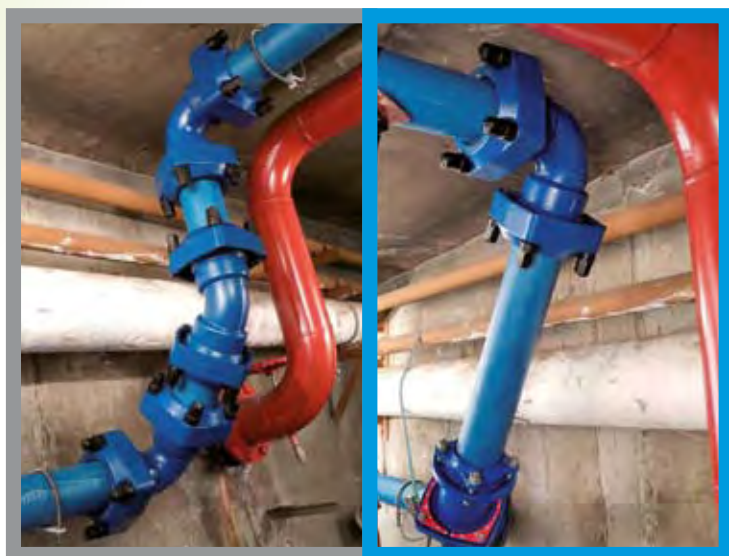
▲ Bez użycia KAMELEO potrzebne jest 5 tradycyjnych kształtek
