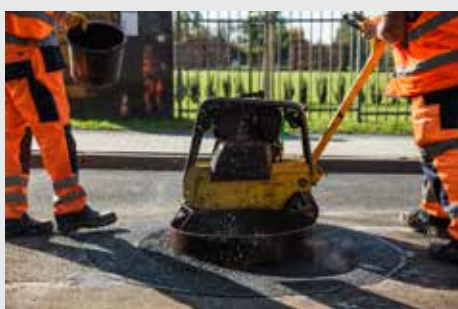
Zagęszczenie nawierzchni
