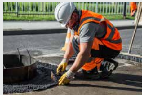
Ułożenie taśmy bitumicznej uszczelniającej połączenie nawierzchni
