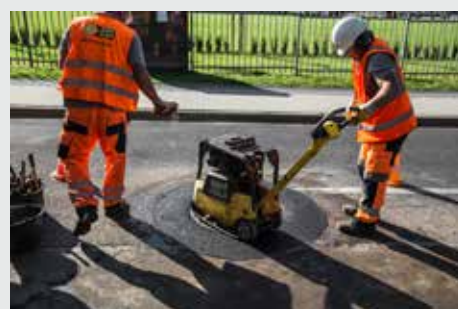
Wprasowanie włazu samopoziomującego Viatop M Niveau do niwelety drogi
