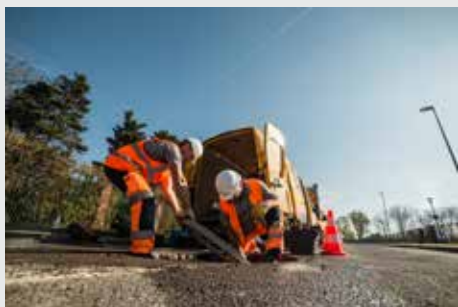
Instalacja pierścienia prowadzącego do studni
