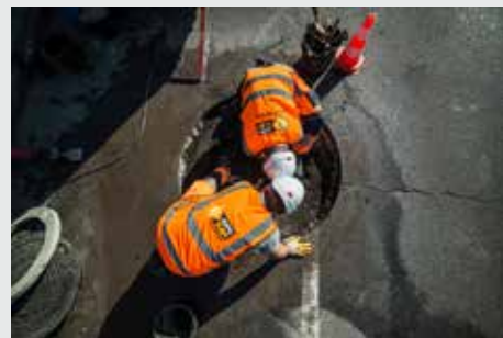
Zakładanie płyty przechwytyjącej nieczystości
