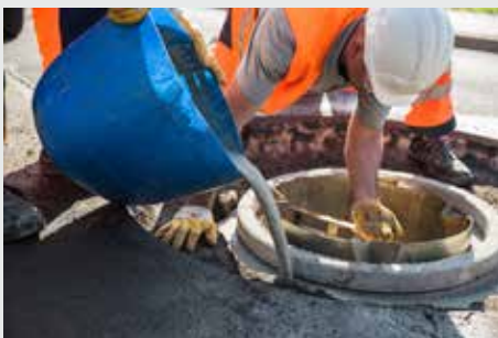
Włożenie szalunku betonowego
