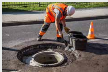
Skropienie podłoża emulsją zwiększającą przyczepność mieszanki mineralno-asfaltowej do podłoża
