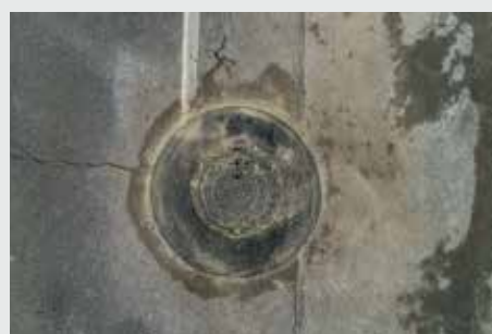
Usunięcie metalowego szalunku i zastąpienie go włazem samopoziomującym Viatop M Niveau
