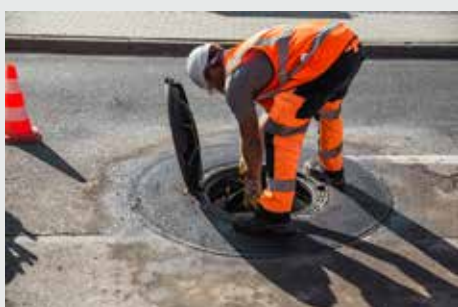
Oczyszczenie uszczelki włazu samopoziomującego Viatop M Niveau
