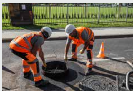
Usunięcie metalowego szalunku i zastąpienie go włazem samopoziomującym Viatop M Niveau
