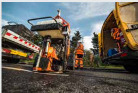
Wycinanie nawierzchni asfaltowej
