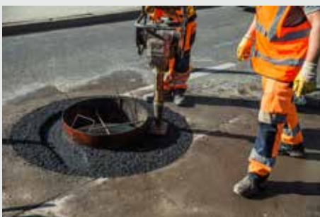
Zagęszczenie nawierzchni
