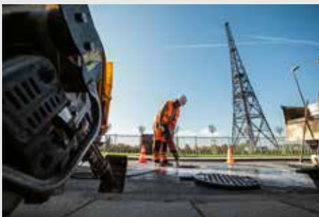
Wykuwanie starego włazu z nawierzchni
