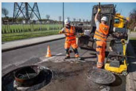
Odtworzenie ubytku nawierzchni
