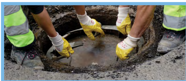
Założenie płyty przechwytyującej nieczystości.
