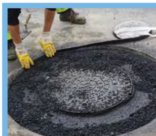
Ułożenie taśmy bitumicznej uszczelniającej połączenie nawierzchni.
