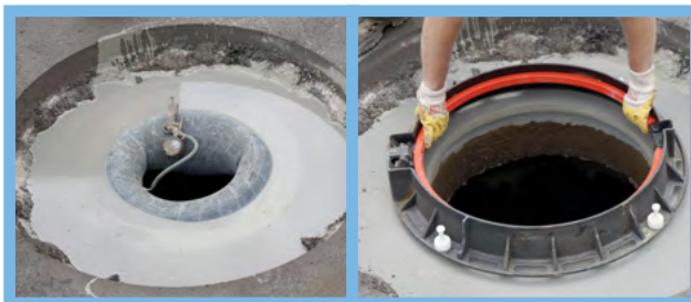
Wykonanie podlewki na zaprawie szybkowiążącej
