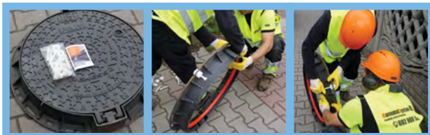
Montaż INSTALL PLUS na ramie włazu Rexess 2.
