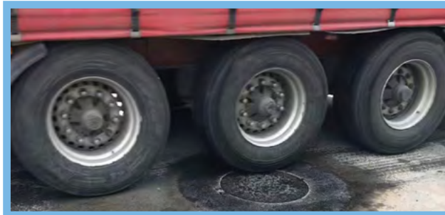
Kilka minut po wznowieniu ruchu ulicznego test montażu włazu przez samochód ciężarowy.
