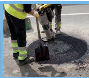
Zagęszczenie nawierzchni wokół włazu.
