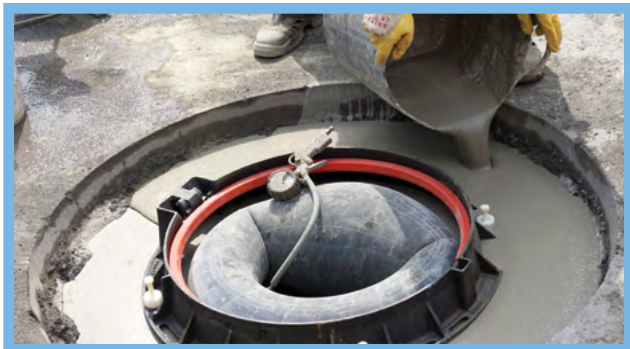
Zalanie wypoziomowanego pierścienia włazu zaprawą szybkowiązącą.
