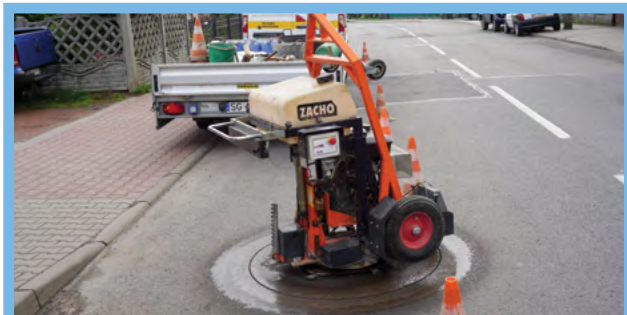
Wycięto nawierzchnię asfaltową wokół starego włazu.
