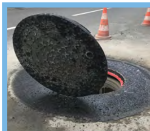
Ułożenie taśmy bitumicznej uszczelniającej połączenie nawierzchni.
