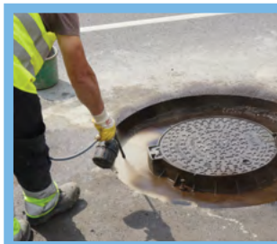
Skropienie podłoża emulsją zwiększającą przyczepność mieszanki mineralno-asfaltowej do podłoża.
