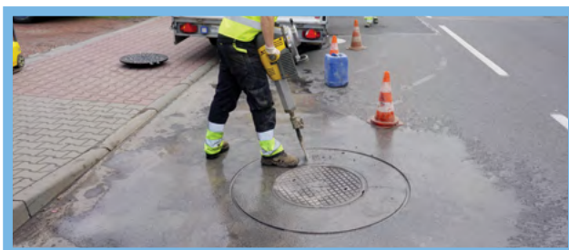
Wykucie nawierzchni bitumicznej.
