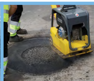
Ostateczne zagęszczenie nawierzchni.
