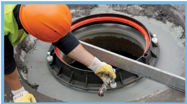
Poziomowanie włazu Rexess 2 za pomocą INSTALL PLUS.
